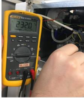
Fan Voltaj Kontrolü
